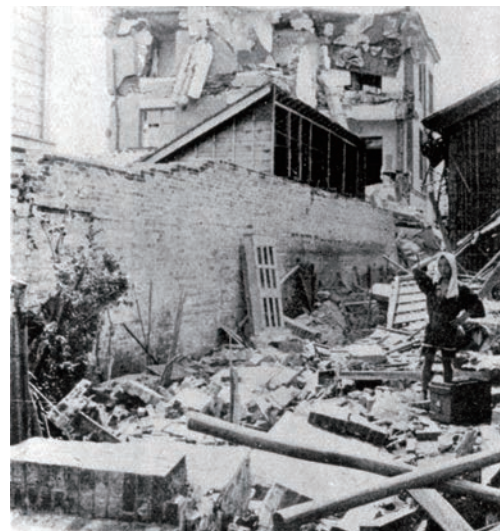
〈照片5〉坍塌的八王子纺织同业组合 （八王子市乡土资料馆收藏）
