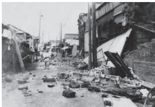
〈照片1〉坍塌的巷弄里的房子（八王子市横山町） （个人收藏、八王子市乡土资料馆提供）
