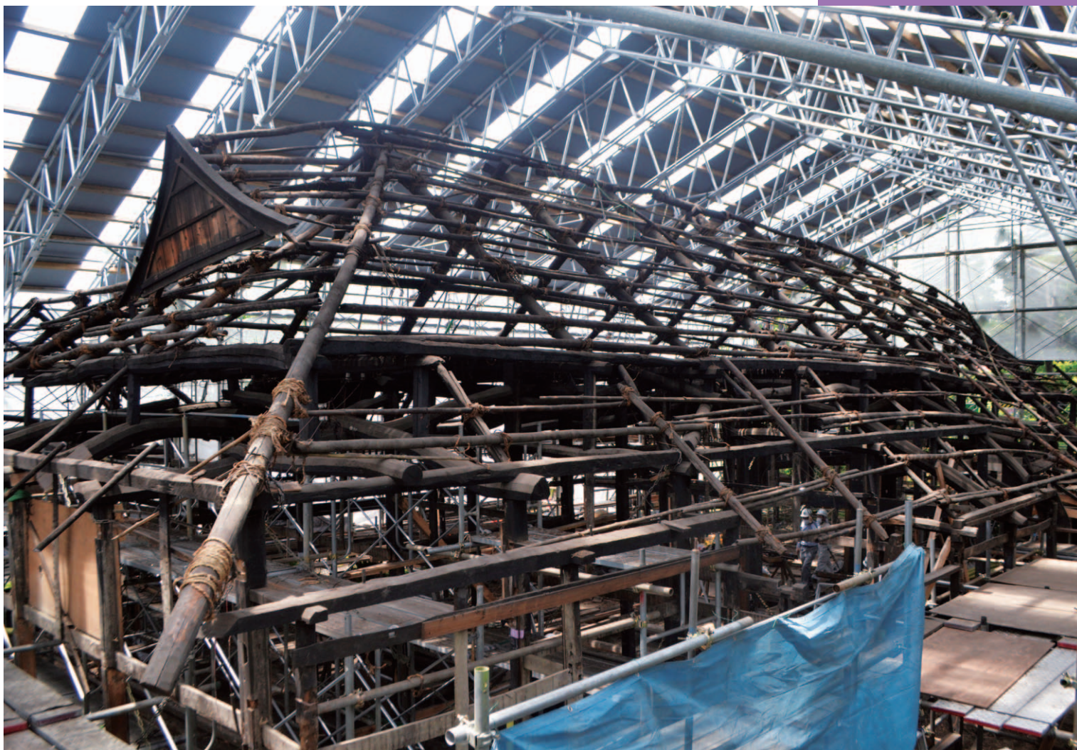
東京都指定文化財「日本田家住宅」開館を目指して、現在、解体調査を実施しています。
