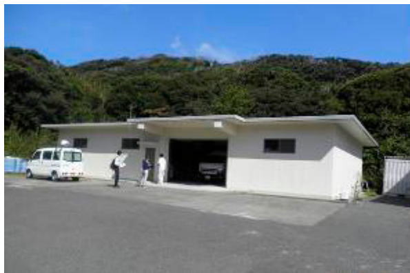
備蓄倉庫外観
