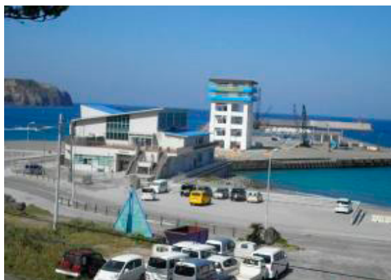
津波避難路②から見た 新島港津波避難施設
