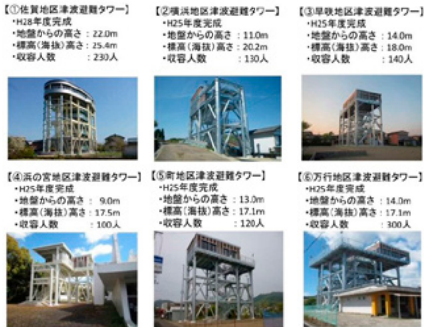
黒潮町の津波避難タワー
