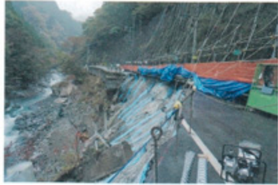
道路崩落の様子
