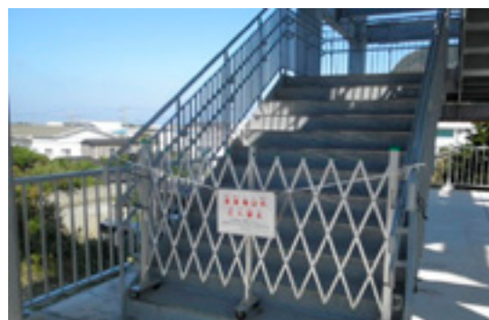
新島村津波避難タワー入口
