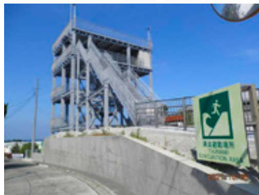
新島村津波避難タワー外観
