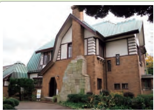
煙突が立派な旧山本有三邸
