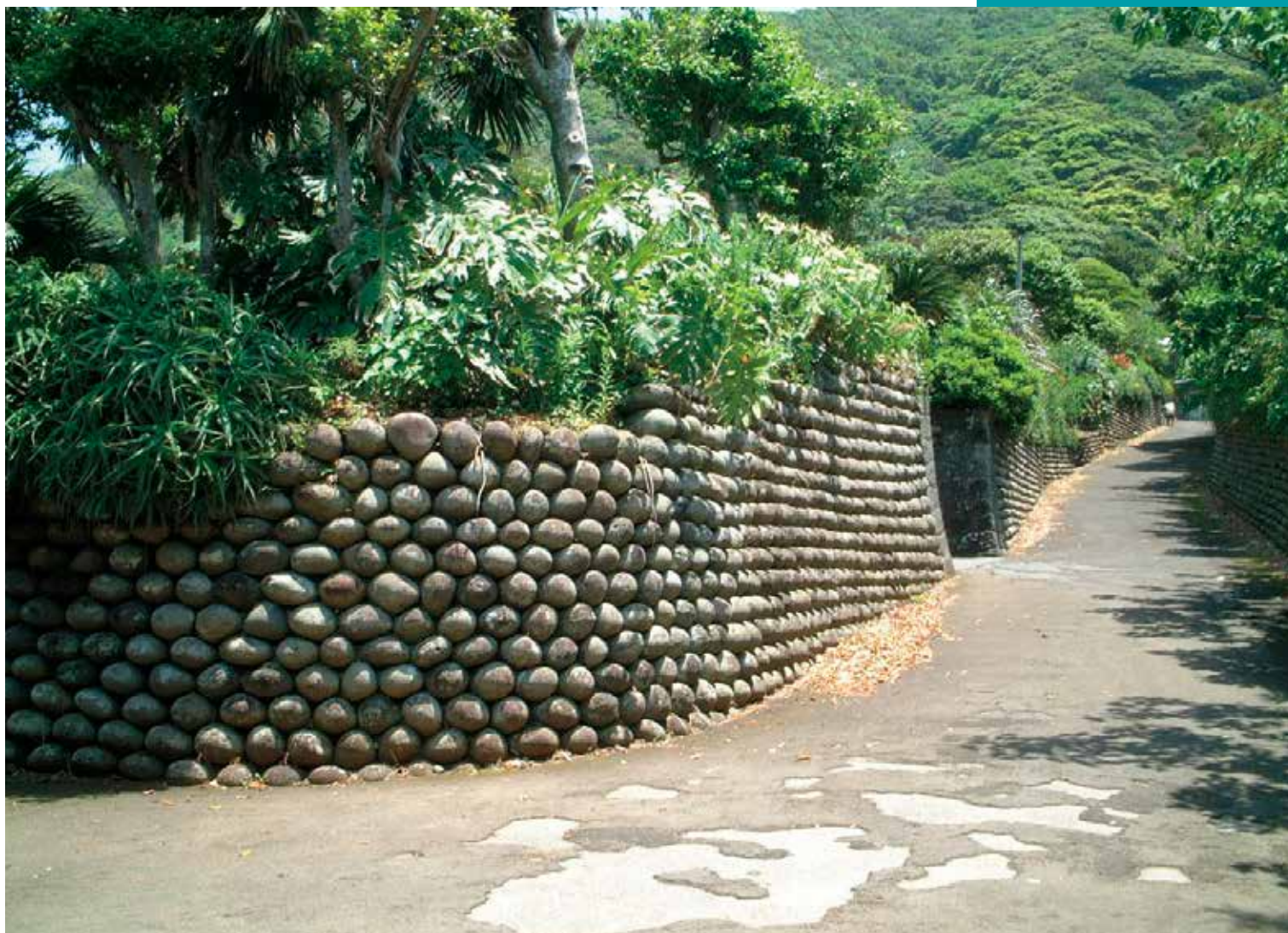
【写真提供】八丈町【撮影場所】大里地区の玉石垣
