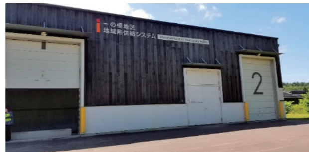
▼一の橋地区地域熱供給施設（筆者撮影）
