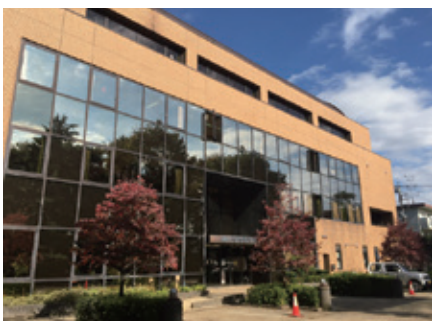
◀国分寺市体育協会が事務所を置く市民スポーツセンター
