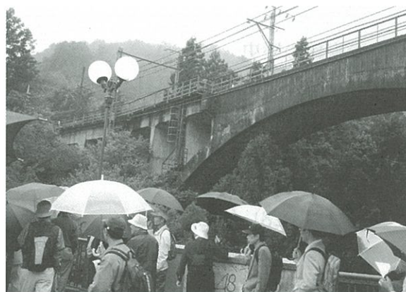
大丹波コンクリートアーチ橋
