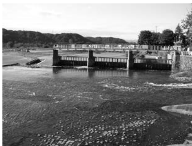
玉川上水羽村取水堰
