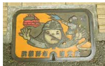
◀【写真1】 路面の消火栓蓋 (武蔵野市境南町)
