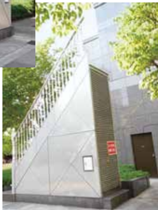
▶【写真11】 ※裏側には地下共同 溝への入口がある
