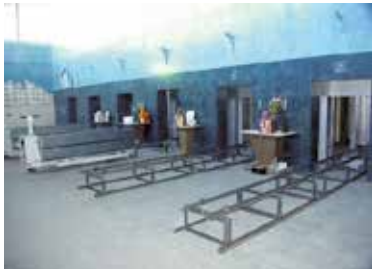
仮復旧を終えた炉前ホール
