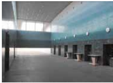
完全復旧した炉前ホール
