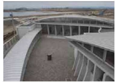
中池を砂利敷きに改修した中庭部分
