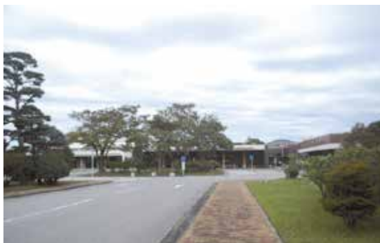
瑞江葬儀所火葬棟外観
