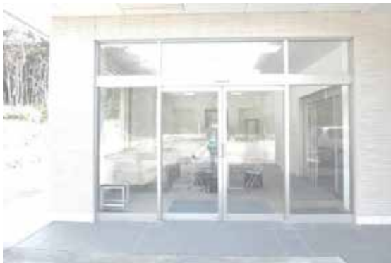
塩害が生じている式根島火葬場
