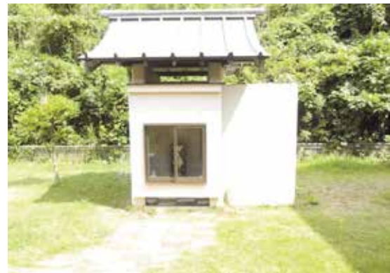
神津島村火葬場の残灰庫
