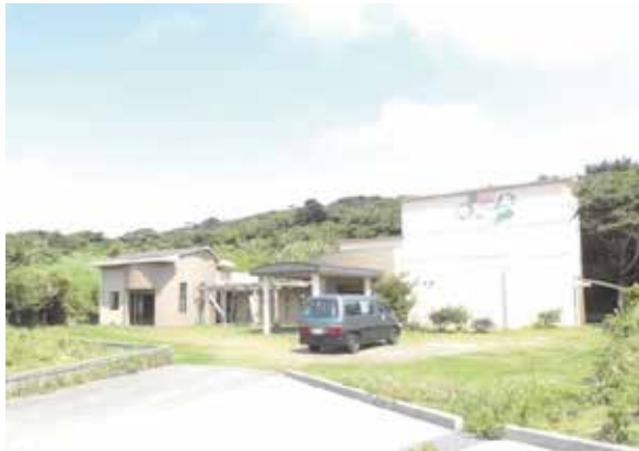
神津島村火葬場外観
