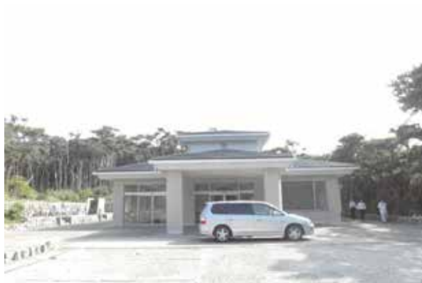
式根島火葬場外観
