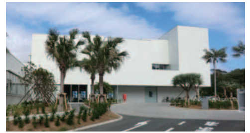
▲平成25年5月に完成した八丈町役場
