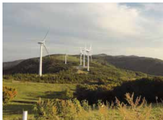
図 5-8 グリーンパワー くずまき風力発電所
