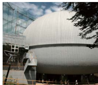
▲多摩六都科学館プラネタリウムドーム “サイエンスエッグ”外観
