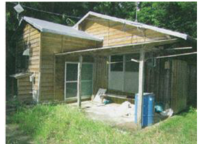
空き家を改修した村営住宅 出典：鹿児島県十島村 HP より
