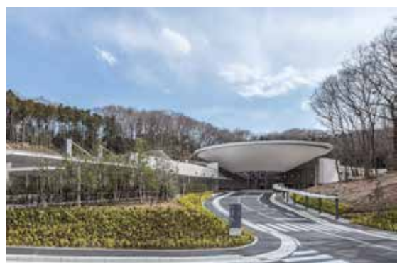
厚木市斎場外観
