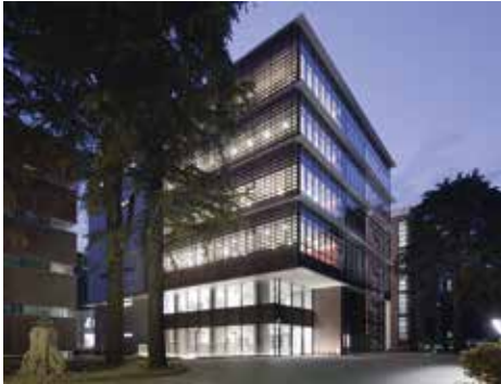
省エネ効果検証対象となった成蹊大学6号館
